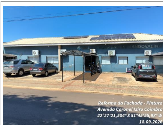
FOTO 18 – Fachada frontal – Reforma e pintura
